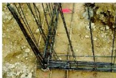
Nœud de chaînage - Continuité mécanique
