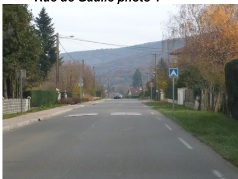
Rue de Gaulle photo 1
